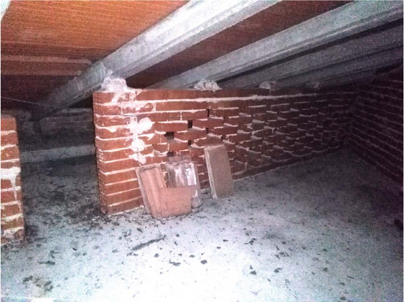
Vista del solaio di sottotetto
