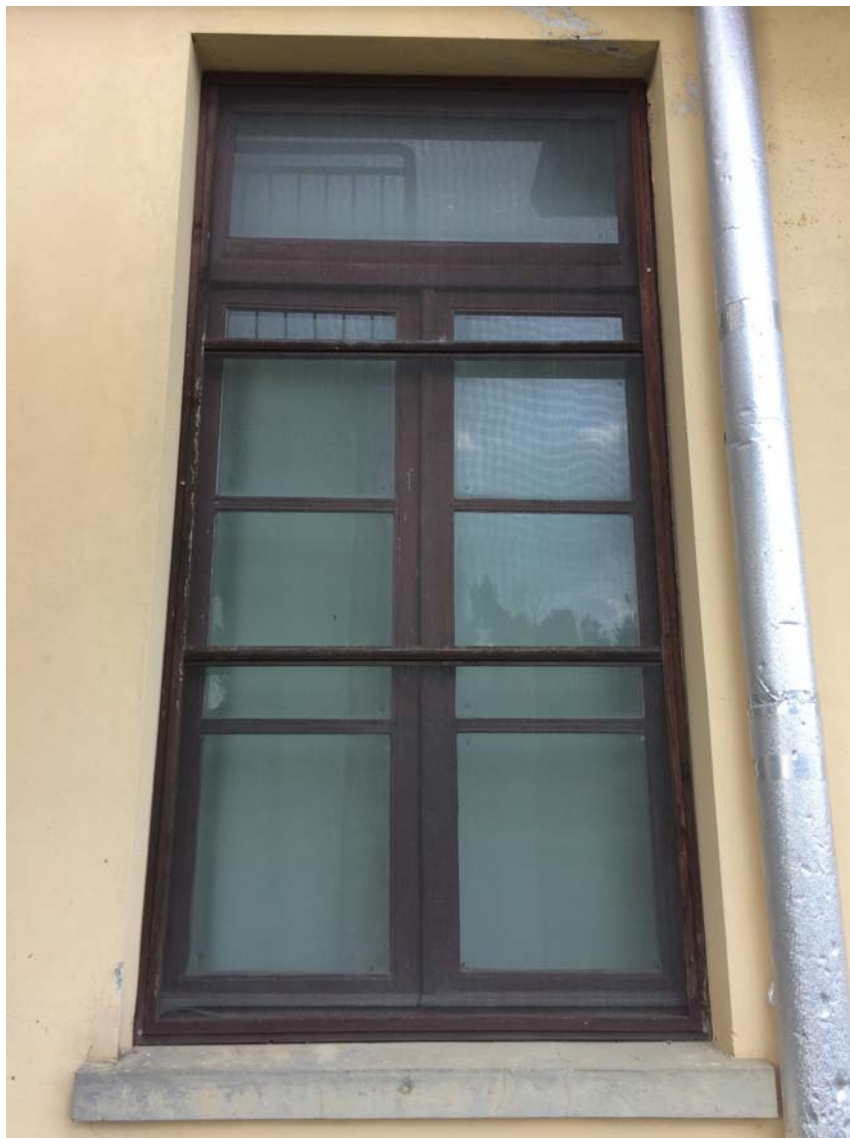
Vista di una finestra esistente
